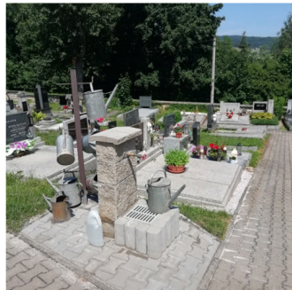
Oprava místa pro odběr vody na hřbitově
