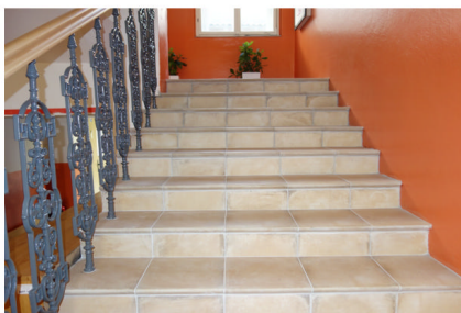
Nová dlažba a zábradlí
