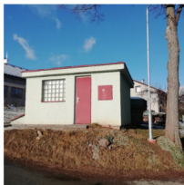
Čerpací stanice ve Velkých Svatoňovicích
