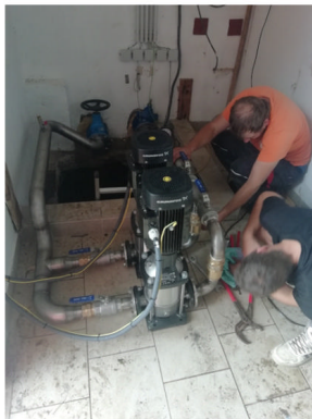
Montáž nových čerpadel
