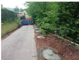
Betonování základních patek
