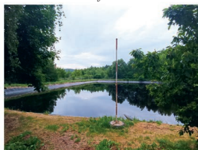
Voda čerpaná ze skládky se formou reverzní osmózy mění ve vodu s vlastnostmi destilované vody a využívá se k zalívce rekultivovaných ploch a zkrápění prašných vozovek.
