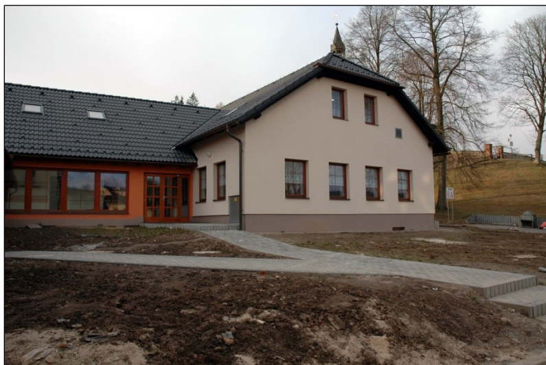
Budova č. p. 161 – sídlo nové obecní knihovny (19. 3. 2009)
