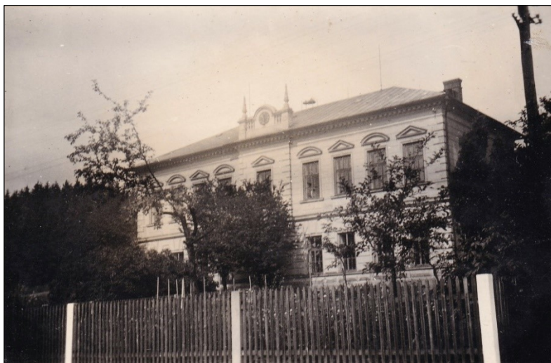
Budova školy v Zálesí (č. p. 181) – sídlo obecní knihovny (1942)
