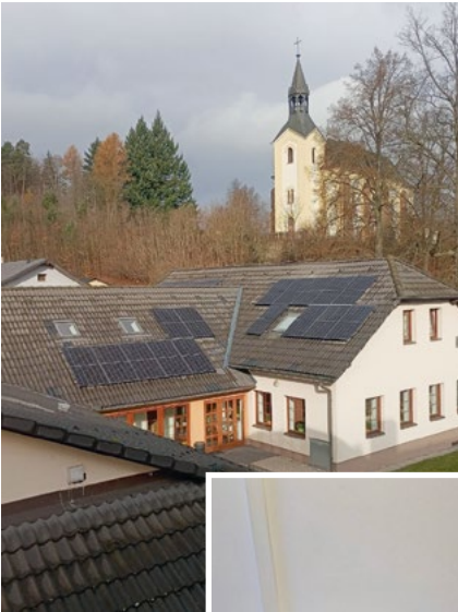
FVE panely na střeše jídelny
