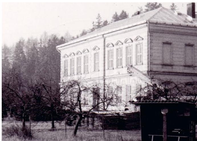
Fotografie školy v Zálesí z roku 1984 po opravě střechy. Atika s hodinami zmizela
