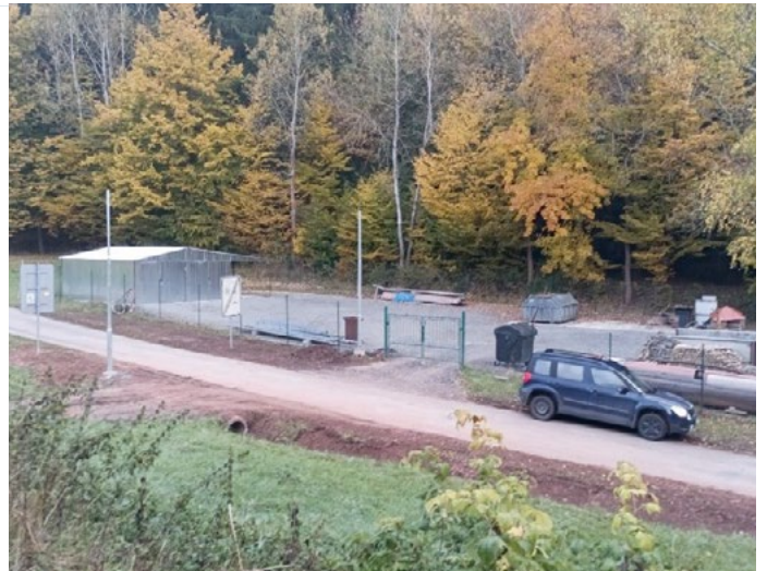
Technické zázemí obce
