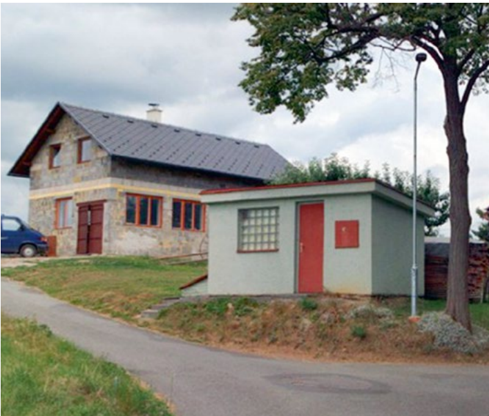
Čerpací stanice ve Velkých Svatoňovicích
