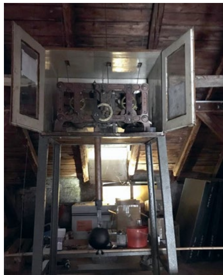
Fotografie původního umístění hodinového stroje na půdě školy (2025)
